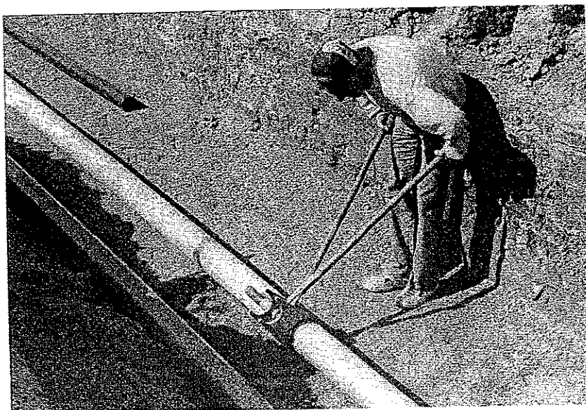
Rörsystemet från Storfors sammanfogas med ett specialverktyg
